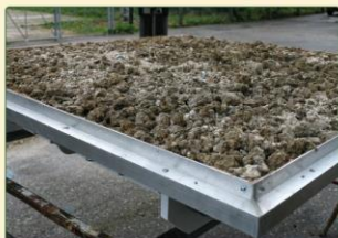
Schwalbenhaus-Konstruktion mit Flachdach © Lukas Howald
